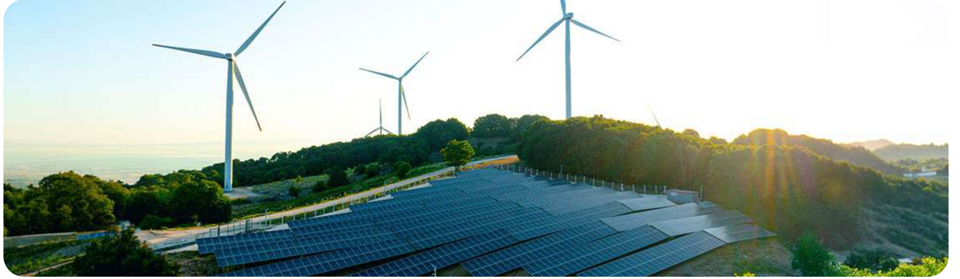
Fiba Yenilenebilir Enerji'ye ait Balıkesir Günaydın Hibrit Enerji Santrali
